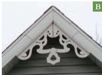
**A** | Exemple d'aisselier assez facile à reproduire dans une pièce de bois massif ou lamellé-collé pour usage extérieur. On découpe à la scie à ruban.
